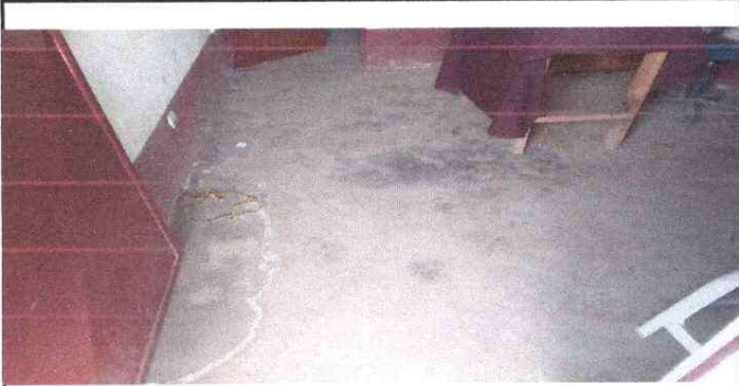
Foto1: 6. PISO Colocación de cerámica en la direccion y bodega.
