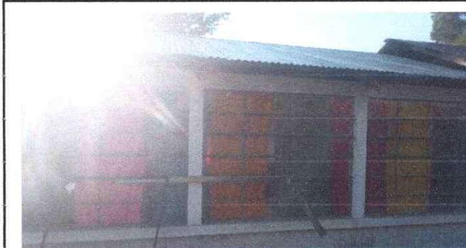
Foto 2: 5 VENTANAS : Sustitución de balcones en aulas bodega y dirección
