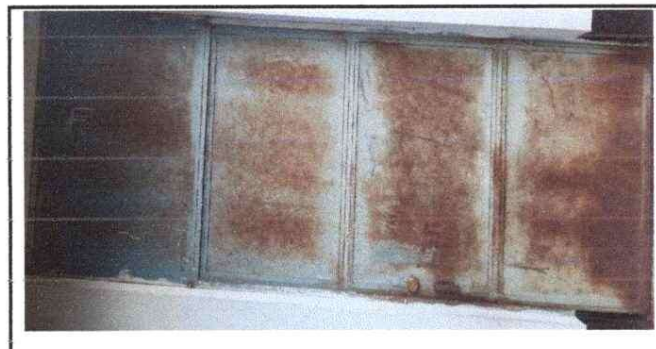
Foto 6: 4. PUERTAS DE METAL: Pintura y lijado de puerta de un aula.
