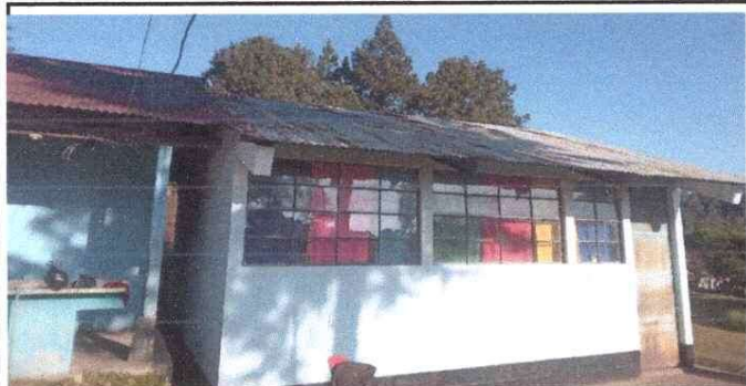
Foto1: 1. CUBIERTA DE LÁMINA: Cambio de lamina de un aula
