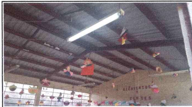
Foto 4: 17 REPARACION DE SISTEMA ELECTRICO: Cambio de focos en todas las aulas
